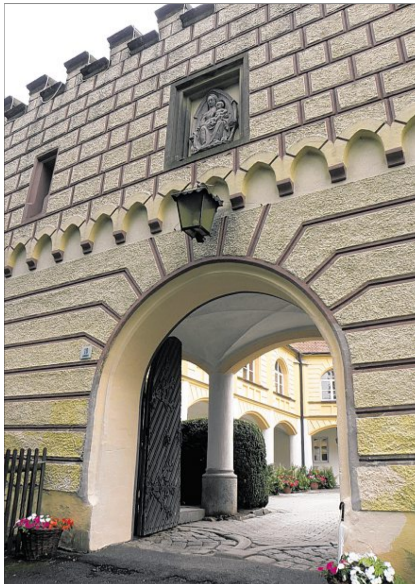
Ein Torbogen führt durch die mächtige Schlossmauer zu dem beinahe italienisch anmutenden Arkadenhof. Bilder: jua (4)
